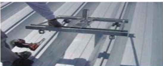
①支柱ベースを仮置きする。その時に、ハゼ金具のナットをインパクトレンチで緩めておく。
