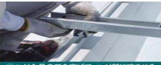
③ハゼ金具の口を広げて、ハゼ部に咬ませるようにセットする。(ハゼ金具4ヶ所)
