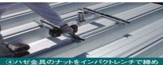
④ハゼ金具のナットをインパクトレンチで締め込み固定する。(ハゼ金具4ヶ所)
