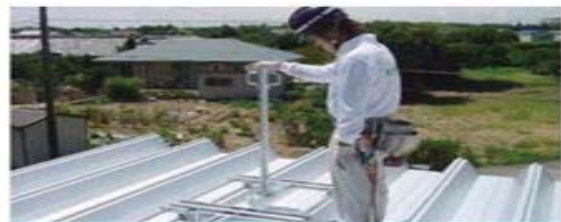
⑤支柱を支柱ベースの中央ソケット部に差し込む。
