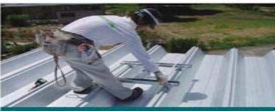
②設置箇所は、親綱システム用支柱の使用基準(表1及び図1)に従って計測して位置決めする。
