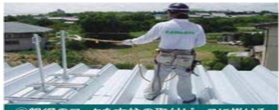
⑦親綱のフックを支柱の取付ベースに掛ける。
