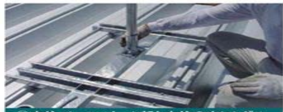
⑥支柱ベースソケット部と支柱の穴にトルグピンで貫通させて固定する。
